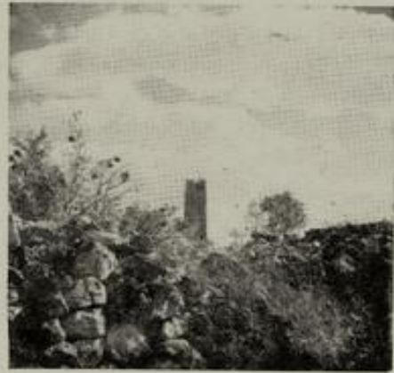
Otro aspecto de la torre de Bufilla.
